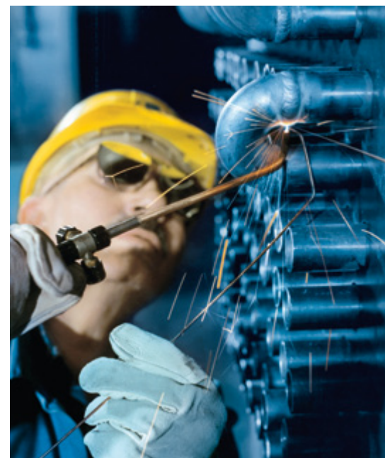
Gassvejsning på varmeveksler.
