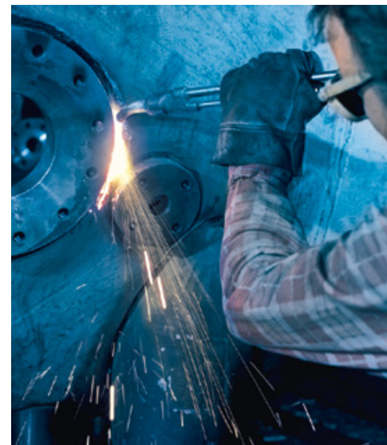
Hulmejsling af rodstrengen før svejsning på modsatte side.
